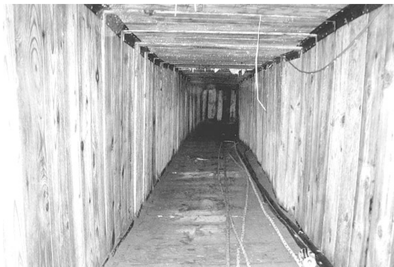
A megerősített oldalfalú alagút
