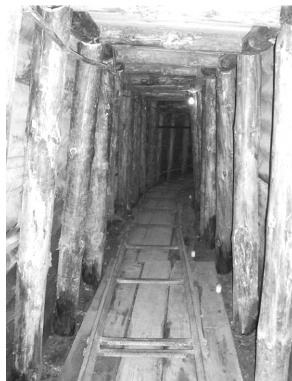
A szarajevói alagút járata
