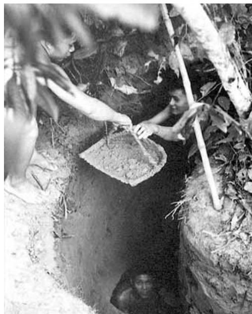
7. kép: Alagút készítése (1965)
